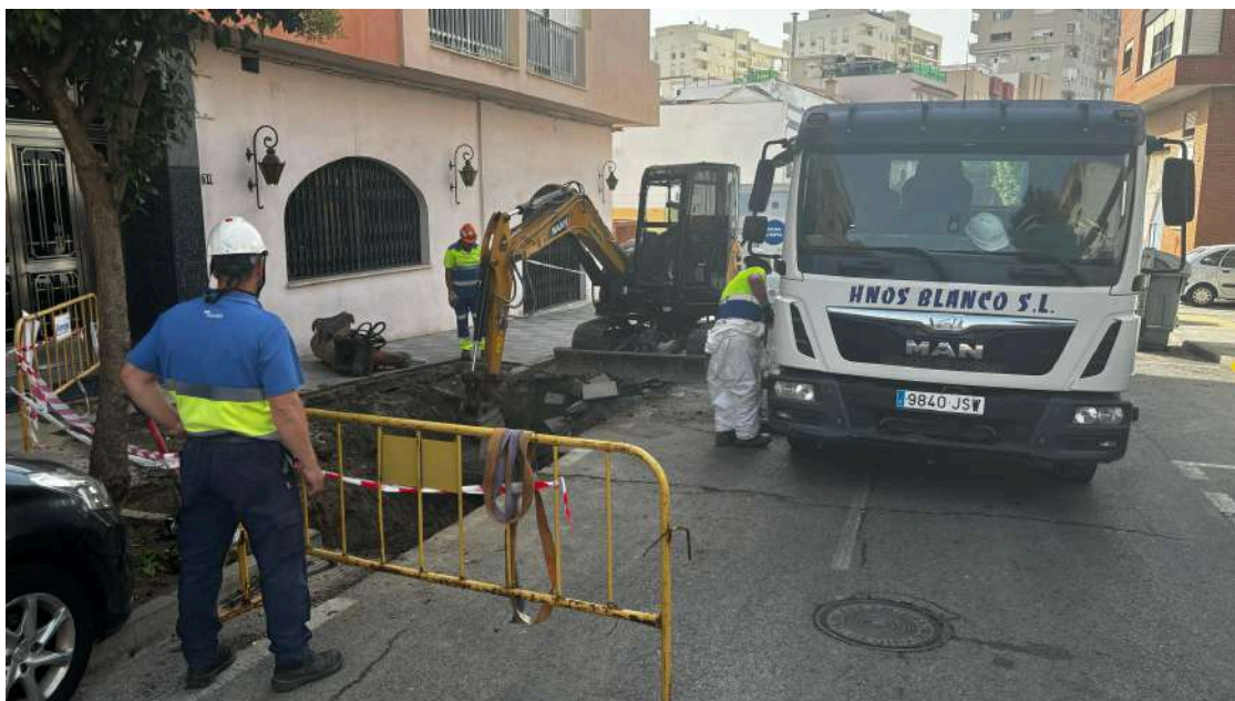
Continúa la reparación de la rotura de tubería en la calle Maestro Millán Picazo.
