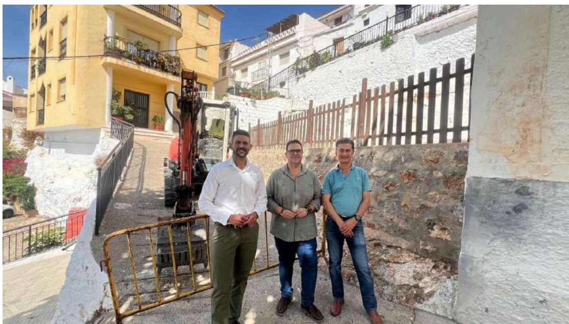
Visita a los trabajos que se están realizando en Lújar
