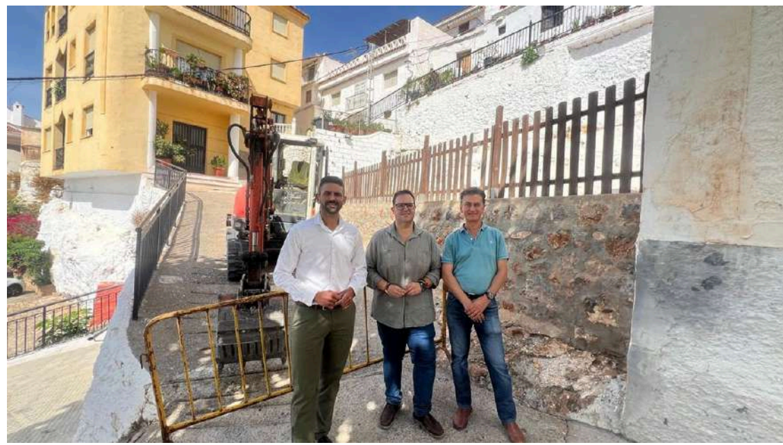
Visitas a las obras (MANCOMUNIDAD)
