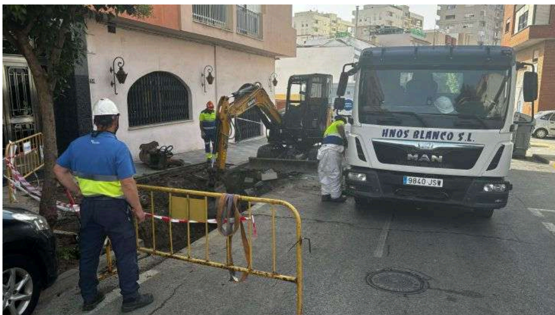
Un momento de los trabajos. / FOTO: AAM
